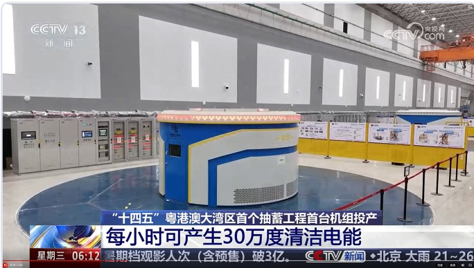
广东梅州抽水储能系统本地监控与可视化
